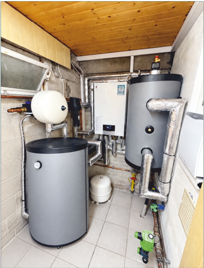
„Platz ist in der kleinsten Hütte“ - eine Wärmepumpeninstallation auf engstem Raum.
